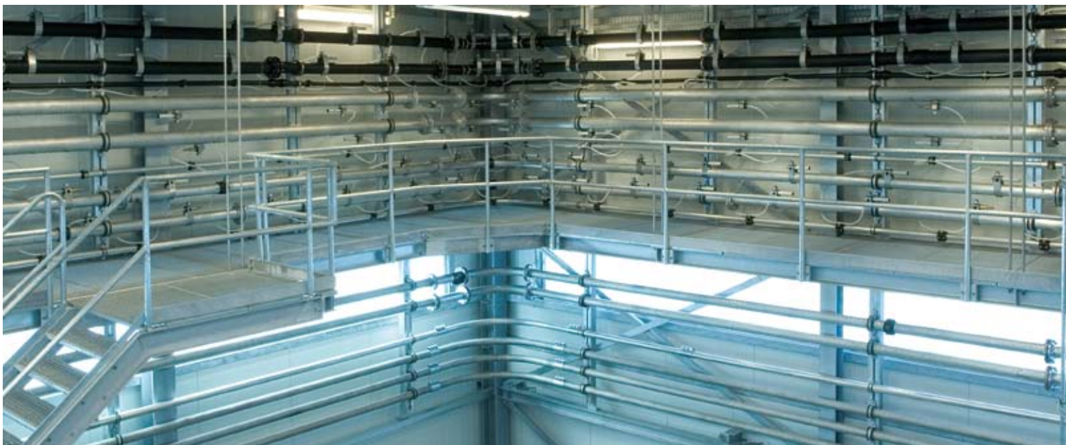
Airfloat mit Rohrleitung aus Chromnickelstahl: Für kritische Produkte wird Luft linienförmig in die Rohrleitung eingeblasen, ohne dass Toträume entstehen.
